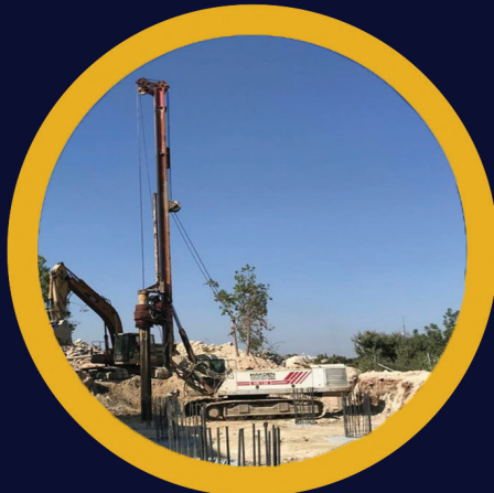
Boğaztepe - Villa Temel Altı Kazık
